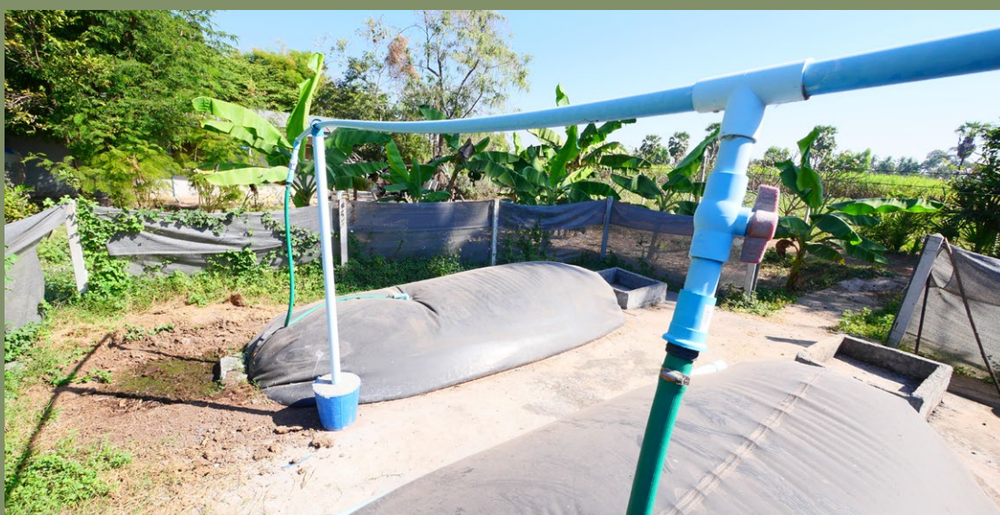
Unidad de biogás en una granja proveedora de Nestlé – Tailandia
