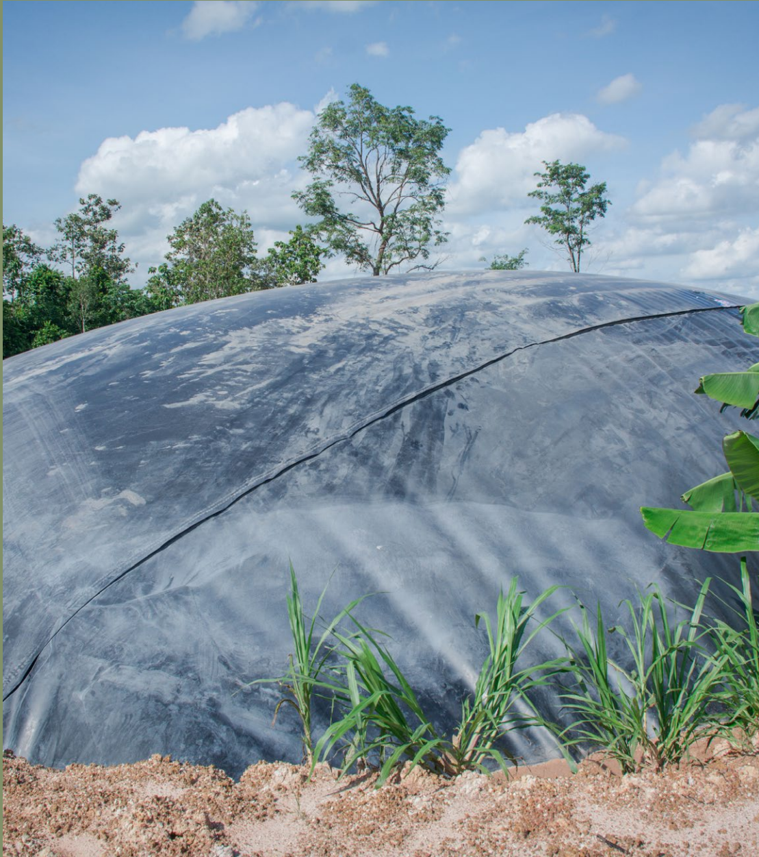
Fotografía: Producción de biogás de laguna anaeróbica
