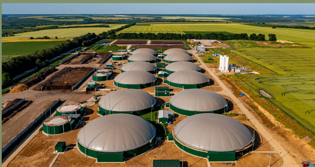
Fotografía: Planta de biogás a gran escala
